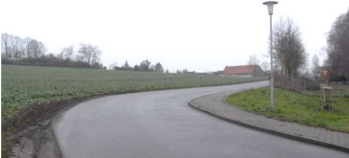
Abb. Nr. 2: Bestandsleuchte im Bereich Gartenstraße, aufgenommen am 24.10.2017
