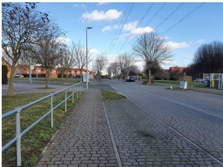
Abbildung 3: Rosenallee mit Zufahrt von Buswendeschleife (Blickrichtung Nordosten)
