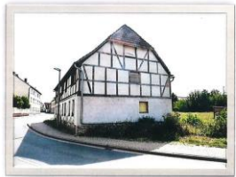
B1.02: Teilanierter Westgiebel
