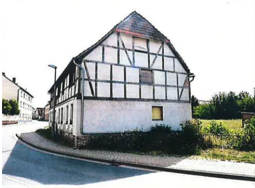
Abb. 2 _ Blick auf den teilsanierten Westgiebel des Gebäudes (Quelle: baufachliche Stellungnahme)
