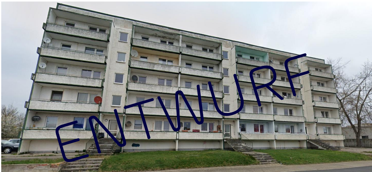
Abbildung 14: freistehendes Mehrfamilienhaus (Baujahr ca. 1970) in Plattenbauweise
